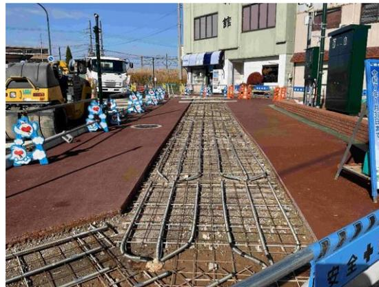
放熱管（ヒートパイプ）設置状況
