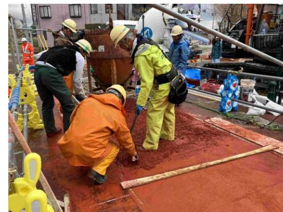
高熱伝導コンクリート打設状況
