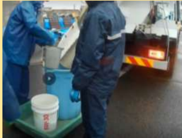
② セメントミルク計測投入
