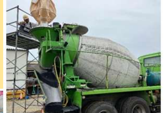
写真9 アルミナ投入状況1
