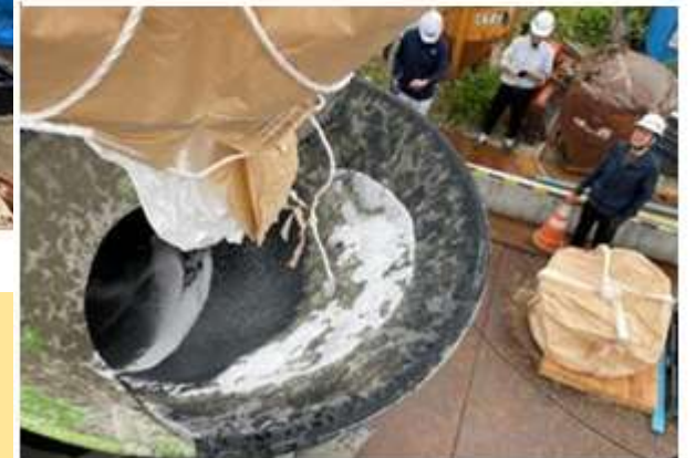
写真10 アルミナ投入状況2
