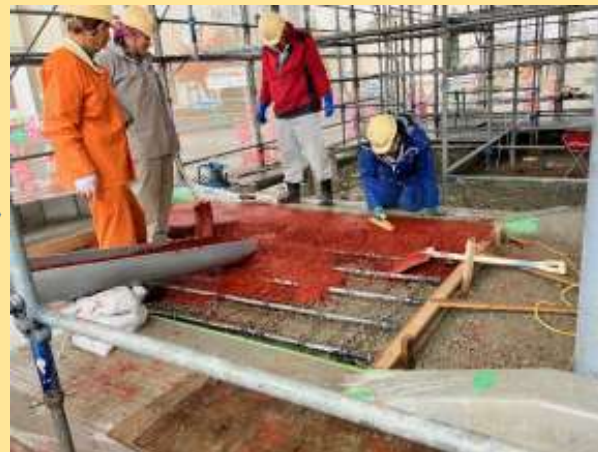
⑤ シュート打設
