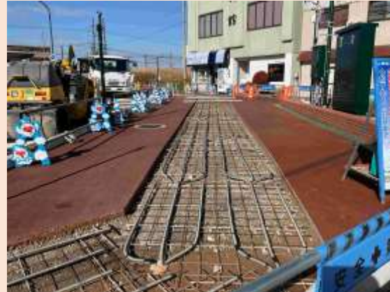
放熱管（ヒートパイプ）設置状況
