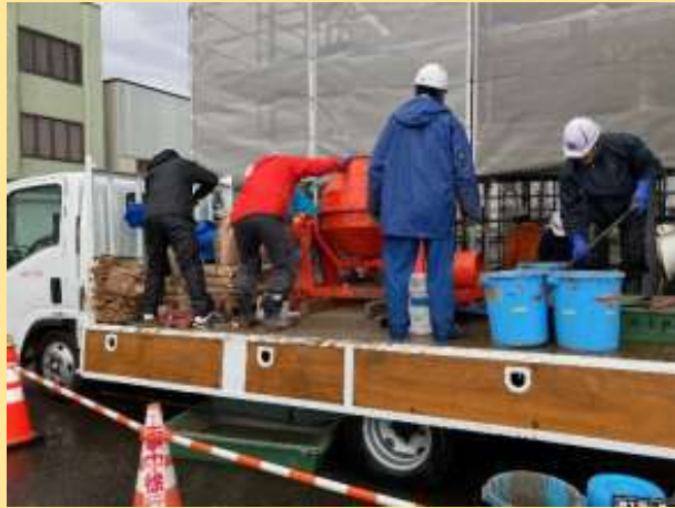
① 碎石計測投入 + アルミナ投入
