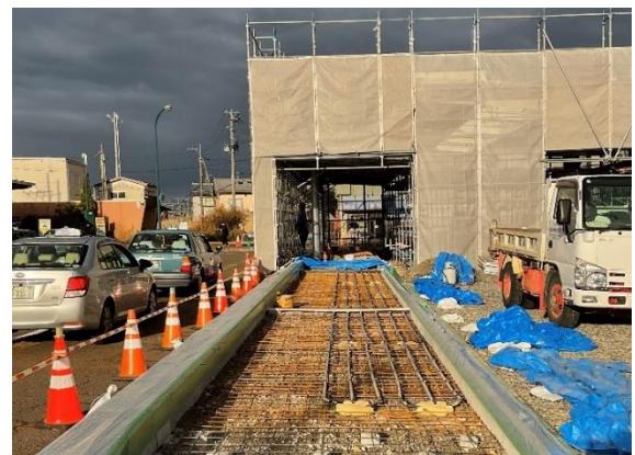
写真2 一般部の放熱管設置状況
