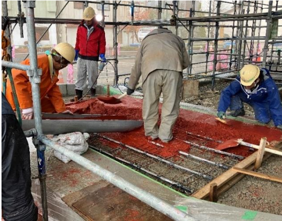
写真5 実験部の放熱管と打設状況
